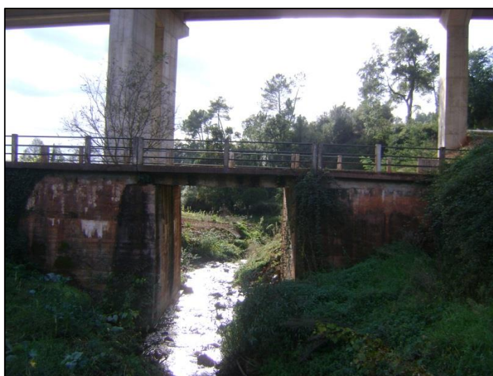
Figura 8 – Ponto de recolha de águas superficiais – Viaduto sobre a Ribeira do Farelo – Montante
