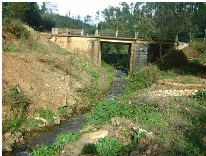
Figura 9 – Ponto de recolha de águas superficiais – Viaduto sobre a Ribeira do Farelo – Jusante
