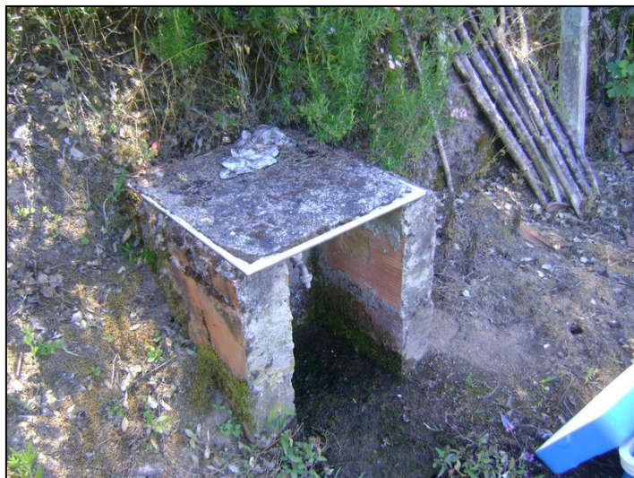
Figura 13 – Ponto de recolha de águas subterrâneas P1, ao Km 1+500.
