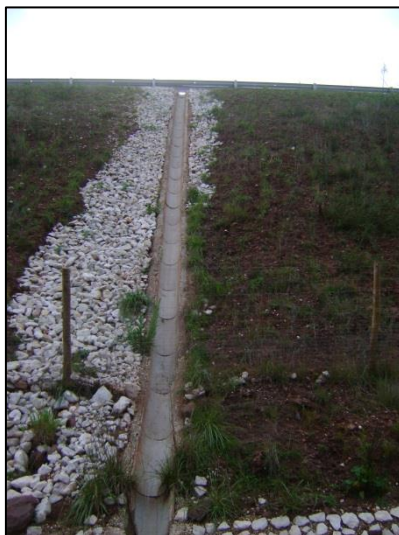
Figura 10 – Ponto de descarga das águas de escorrência da via localizado ao km 2+425
