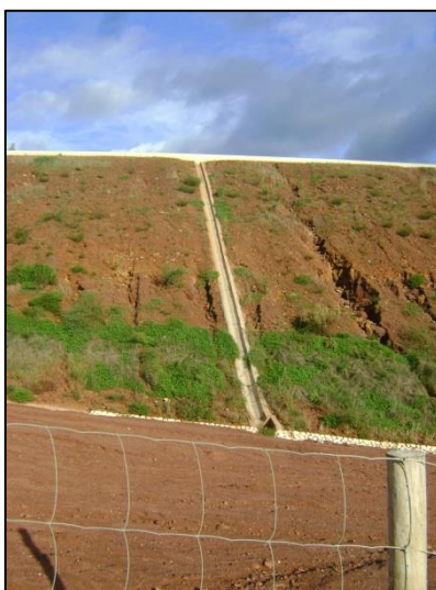
Figura 12 – Ponto de descarga das águas de escorrência da via localizado ao km 7+350
