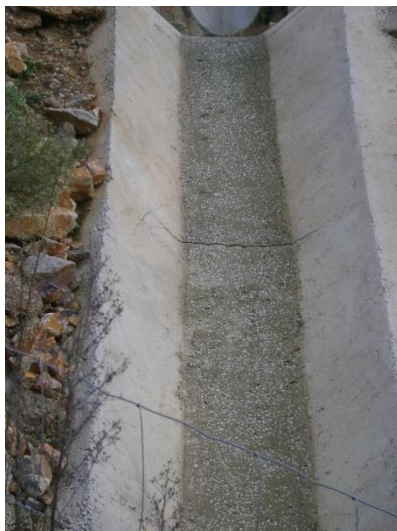
Figura 11 – Ponto de descarga das águas de escorrência da via localizado ao km 3+400
